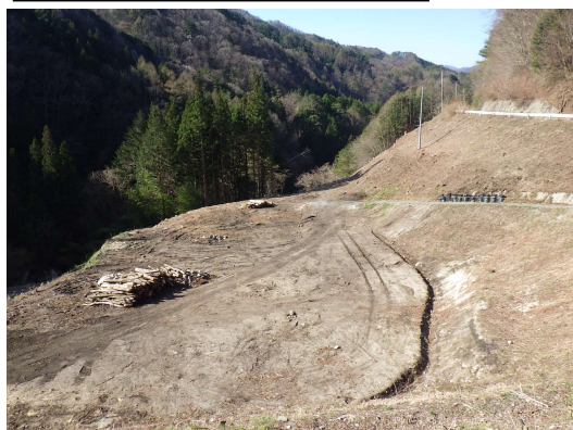
伐採（施工ヤード）
