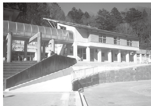
浪合小学校改修工事
