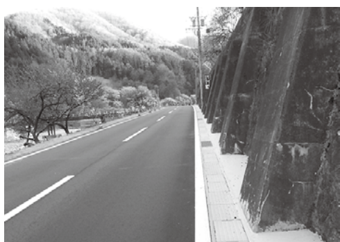
村道 2-17 号線改良工事
