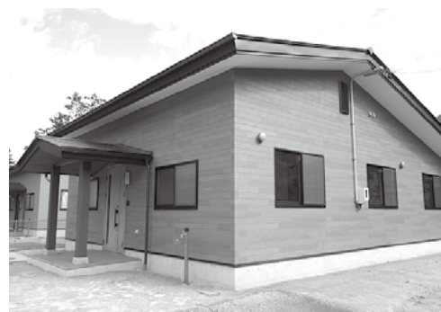
定住促進住宅建設工事（智里中央）
