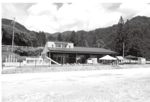
智里西保育園改築工事
