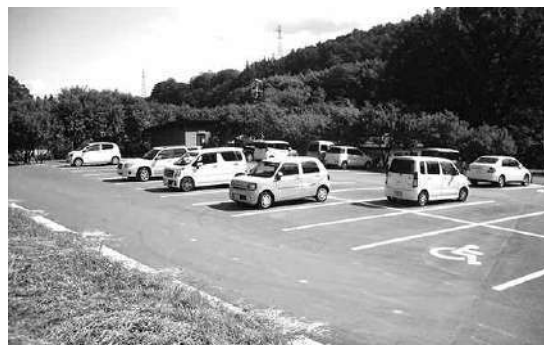
(仮称) 阿智昼神パーキング整備工事
