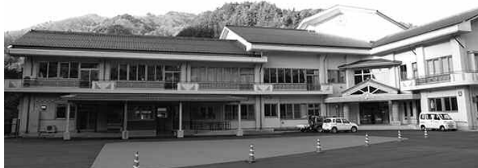
旧清内路中学校改修工事
