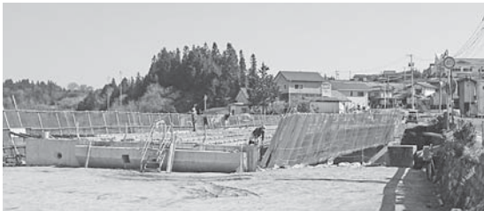
中之橋工事の様子
