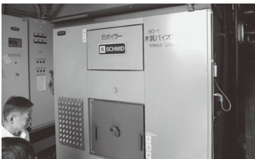
チップボイラー
