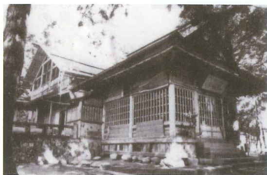
安布知神社の拝殿と本殿覆屋
