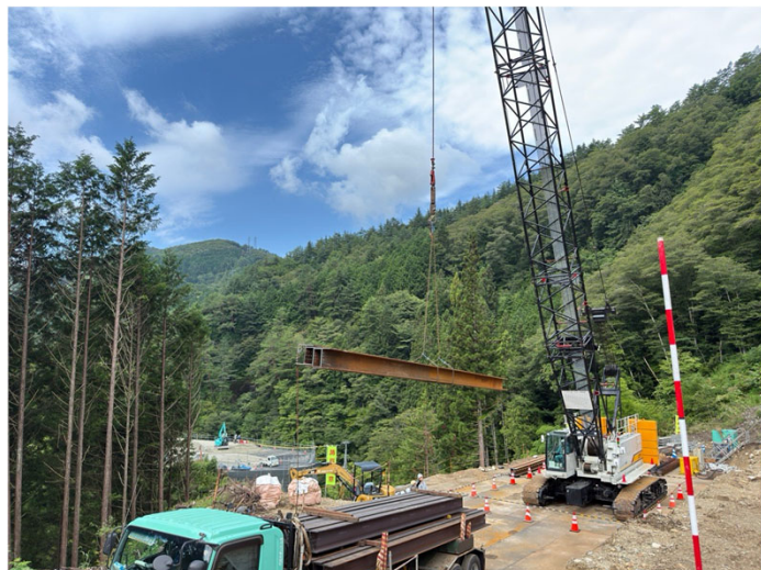
う回路工事 クレーン作業の状況
