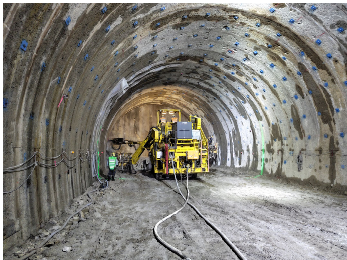
9月末の斜坑進捗54m 切羽作業の状況
