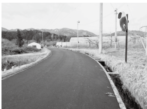
公共施設等適正管理推進事業（長寿命化） 舗装修繕工事（東栗矢）
