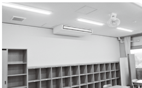
3階学習室4に空調設置（中学校）
