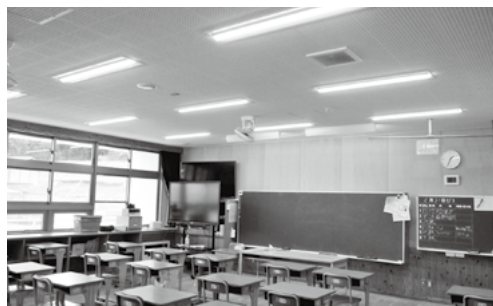
南校舎2階・3階照明のLED化（中学校）
