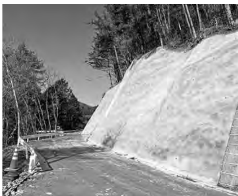
村道 3-639 号線拡幅工事
