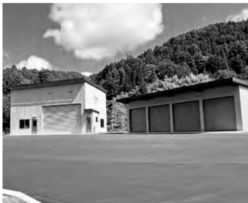
凍結防止剤倉庫（上清内路）
