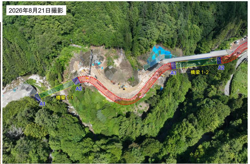
う回路工事の全景写真
