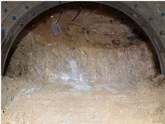
8/31現在、斜坑進捗39m 切羽の状況
