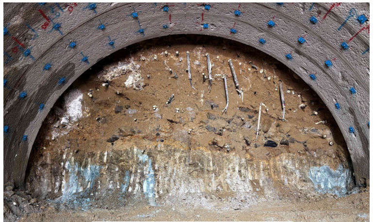
斜坑28m地点の切羽状況
