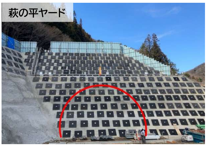
斜坑 正面から撮影
