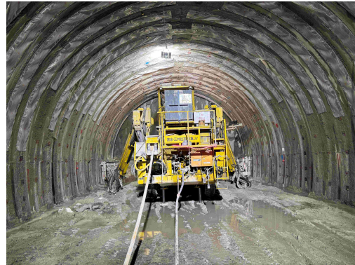
ロックボルト打設
