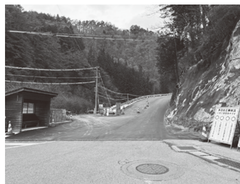
村道1-20号線拡幅工事後の様子
