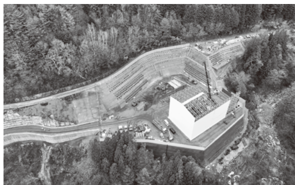
トンネル掘削工事が開始される萩の平ヤード(清内路)
