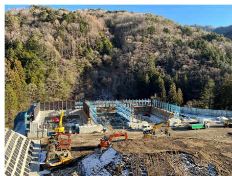
非常口ヤード トンネル仮設備工(ずりピット工) 2026年1月7日
