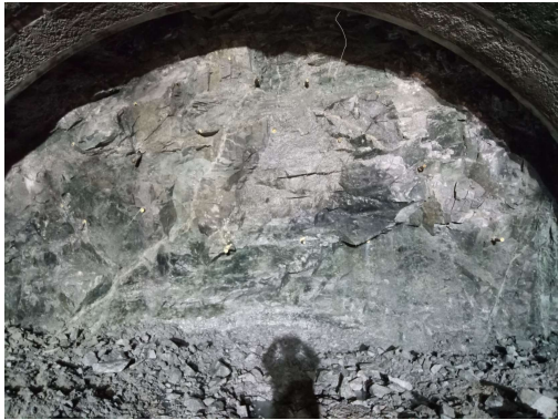
斜坑_切羽状況_Ok629m
