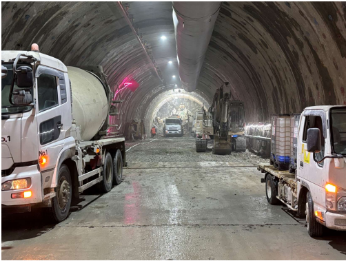
吹付コンクリート施工状況
