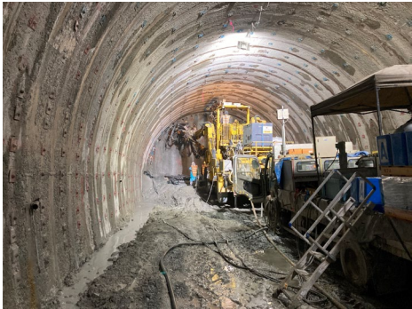
補助工法（AGF）施工状況
