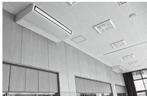
多目的集会室の空調設置（中学校）
