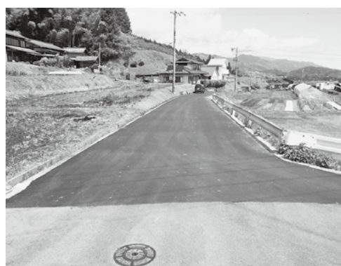
村道舗装補修工事（2-5 号線 伍和 上郷）
