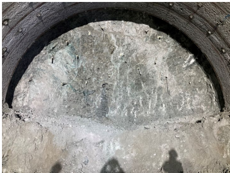
斜坑_切羽状況_Ok515m
