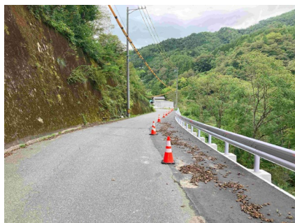
村道区間②下流 村道拡幅完了 2025年10月2日
