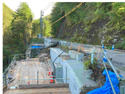
村道区間②池の洞 パンウォール工 2025年10月2日
