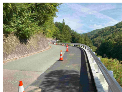
村道区間③ 村道拡幅完了 2025年10月2日
