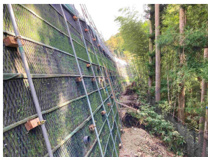
非常口ヤード 土工事_補強盛土 2025年10月2日
