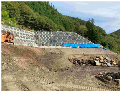
非常口ヤード 法面工事 2025年10月2日
