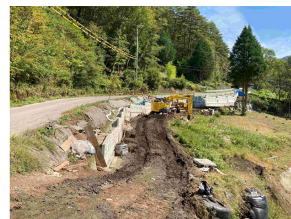
村道区間③-1 パンウォール工 2025年10月2日
