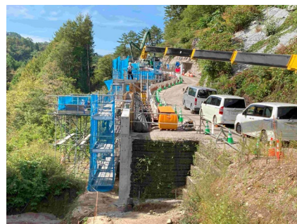
非常口進入路 壁面工 2025年10月2日
