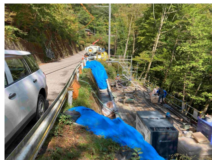
村道区間②-3 パンウォール工 2025年10月2日
