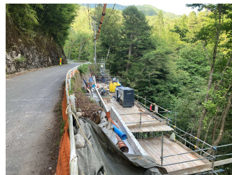
村道区間②-2 パンウォール工 2025年9月2日
