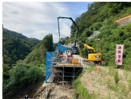
非常口進入路 壁面工 2025年9月4日
