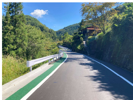
村道区間①上流 村道拡幅完了 2025年9月3日
