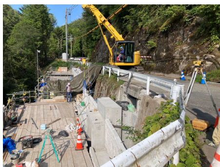
村道区間②池の洞 BOX擁壁工 2025年9月2日
