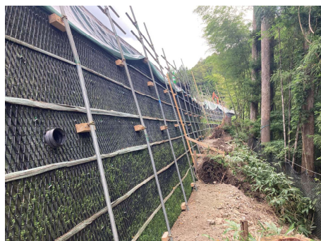
非常口ヤード 土工_補強盛土 2025年9月2日
