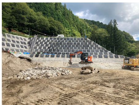
非常口ヤード 法面工事 2025年9月2日
