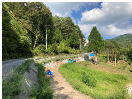
村道区間③ パンウォール基礎工 2025年9月2日
