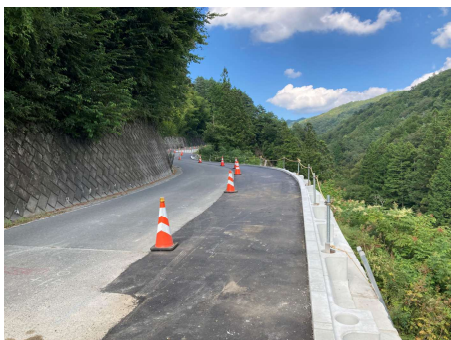
村道区間⑤ 舗装工完了 2025年9月2日
