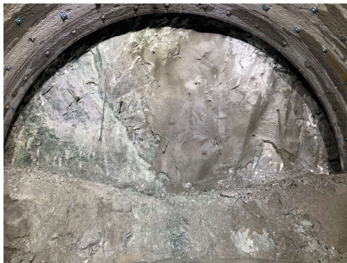
斜坑_切羽状況_Ok459m
