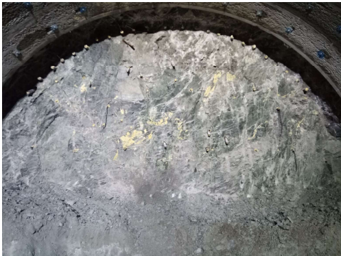
斜坑_切羽状況_Ok430m
