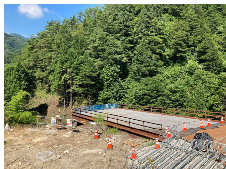
う回路 仮栈橋工 2025年7月30日
