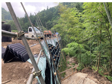
非常口ヤード 土工_補強盛土 2025年8月5日
