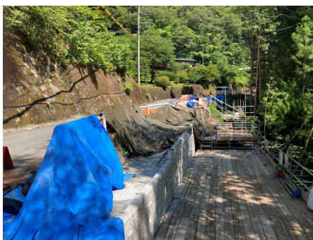
村道区間②-3 パンウォール工 2025年7月30日
