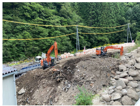
う回路 地盤改良工 2025年8月5日
