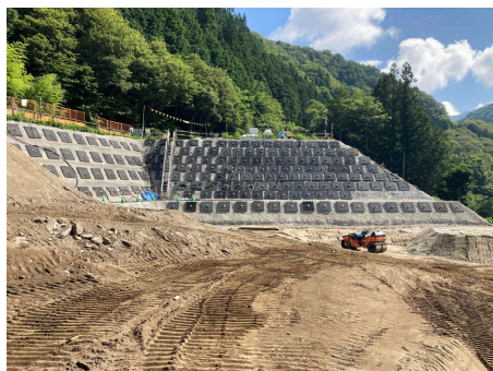
非常口ヤード 法面工事 2025年7月30日
