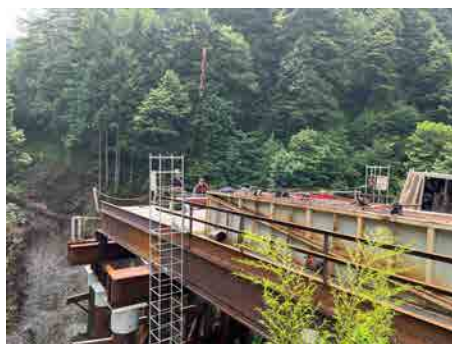
う回路 仮橋工 2025年7月7日
