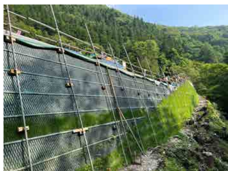
非常口ヤード 土工_補強盛土 2025年7月7日
