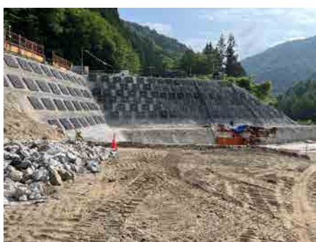
非常口ヤード 法面工事 2025年7月7日
