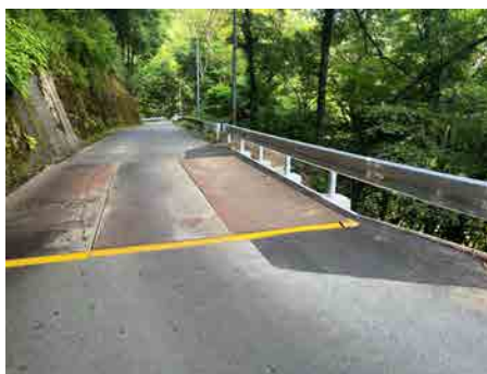
村道陥没箇所 復旧しました 2025年7月7日
