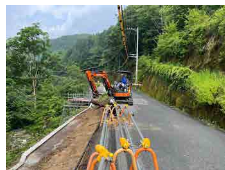
区間②-1 路盤掘削工 2025年7月7日
