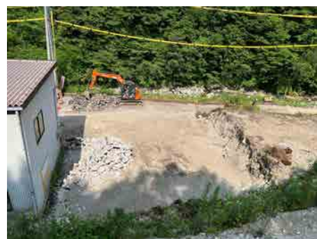
う回路 シビエ加工所解体工 2025年7月7日
