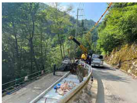
村道区間②-4 パンウォール工 2025年7月7日
