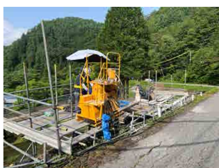
村道区間③ 擁壁裏込注入工 2025年7月8日
