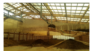
堆肥センター屋根工事
