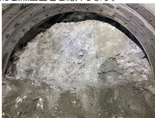
斜坑_切羽状況_Ok326m
