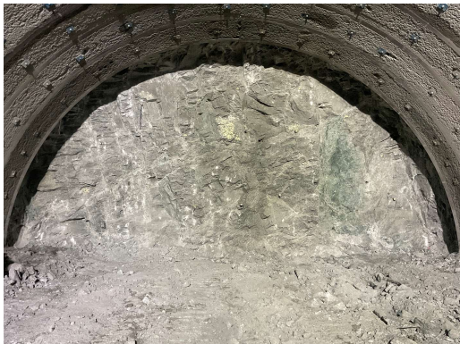
斜坑_切羽状況_0k266m
