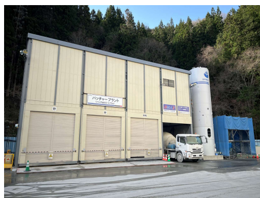
バッチャープラント
