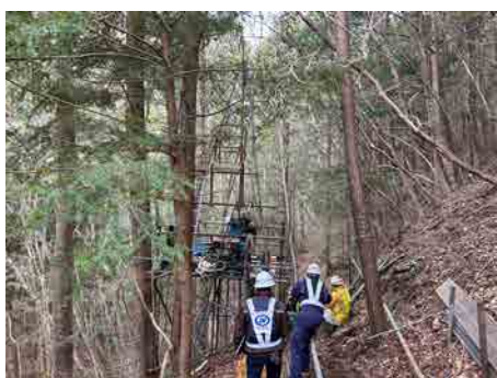
クララ沢進入路 地質調査工 2025年3月24日
