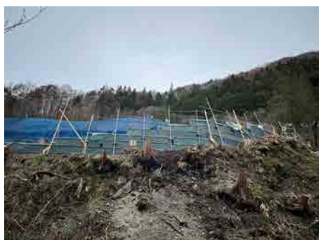
非常口ヤード 土工_補強盛土 2025年4月2日
