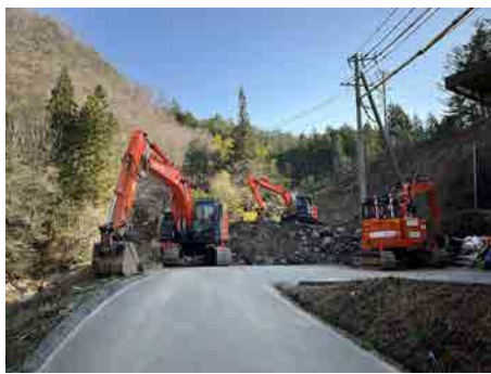
区間①迂回路 地盤改良工 2025年4月8日
