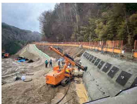
非常口ヤード 法面工 2025年4月3日
