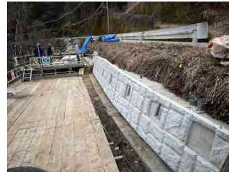
村道区間②-1 パンウォール工 2025年4月2日
