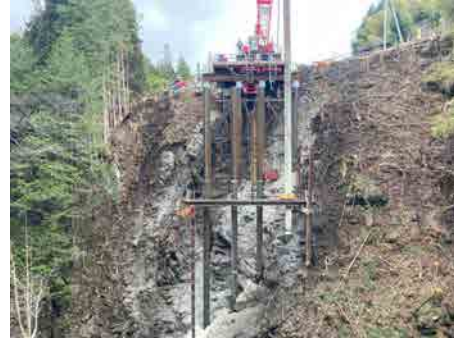
区間①迂回路 仮栈橋工 2025年3月28日
