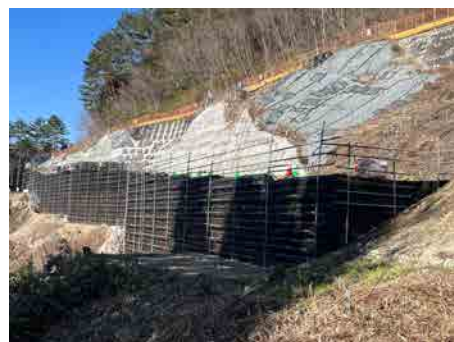
非常口ヤード進入路 補強盛土工 2025年4月9日
