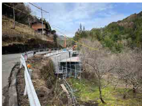
村道区間① ガードレール基礎 2025年4月2日
