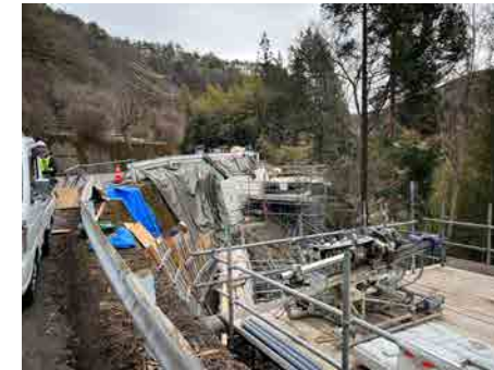
区間②-5 パンウォール工 2025年4月2日
