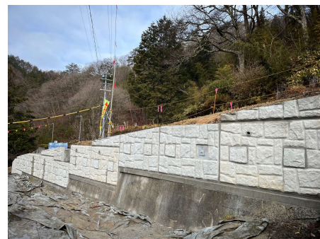
村道区間③ パンウォール工_完了 2025年3月12日
