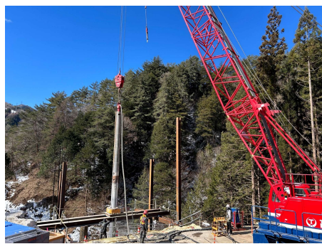
区間①迂回路 仮栈橋工 2025年2月24日
