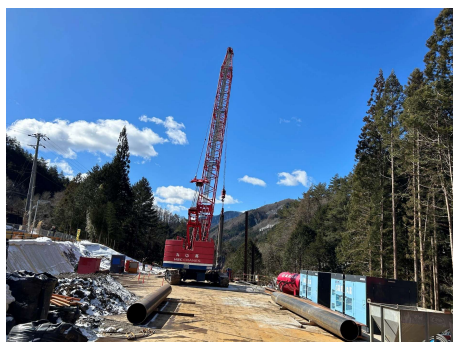
区間①迂回路 仮栈橋工 2025年2月24日
