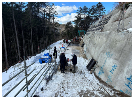
非常口ヤード進入路 補強盛土工 2025年2月24日
