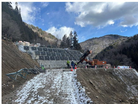
非常口ヤード 法面工 2025年2月24日
