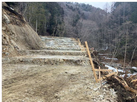
非常口ヤード 土工事_床付状況 2025年3月7日
