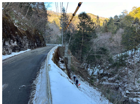
村道区間② パンウォール足場工 2025年2月25日
