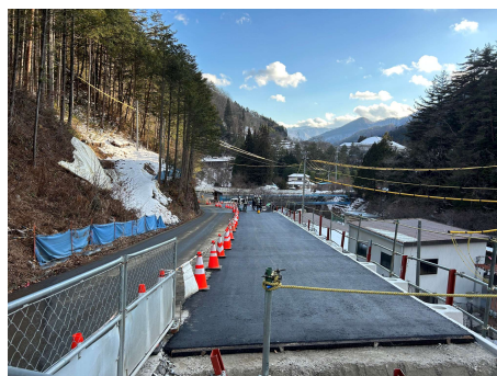
村道区間①下流 舗装工_完了 2025年2月26日
