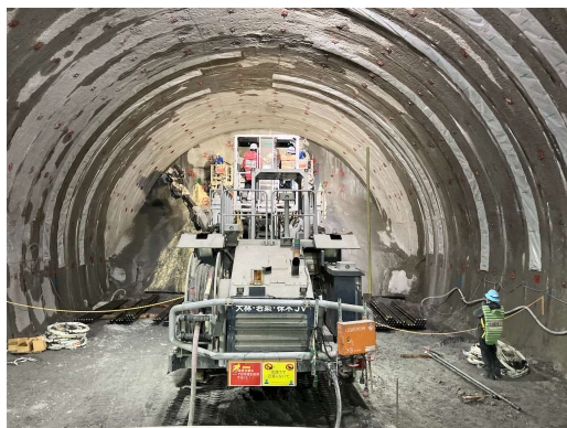
本坑（名古屋方）掘削状況
