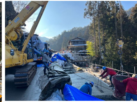
区間①上流 パンウォール工 2025年1月24日
