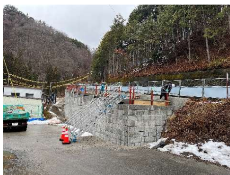
村道区間①下流 ガードレール基礎 2022年2月3日
