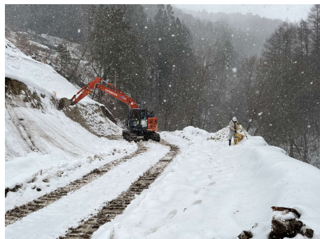
非常口ヤード 土工事 2024年12月24日
