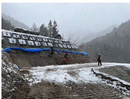
非常口ヤード 法面工 2025年2月13日
