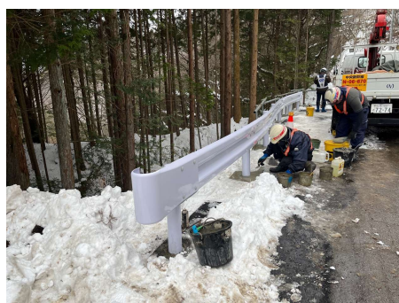
村道区間④ ガードレール工 2025年2月12日
