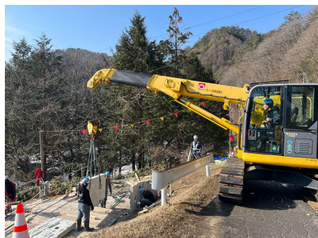
区間③ パンウォール工 2025年1月23日
