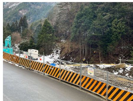
区間①迂回路 ヤード造成工 2025年2月3日
