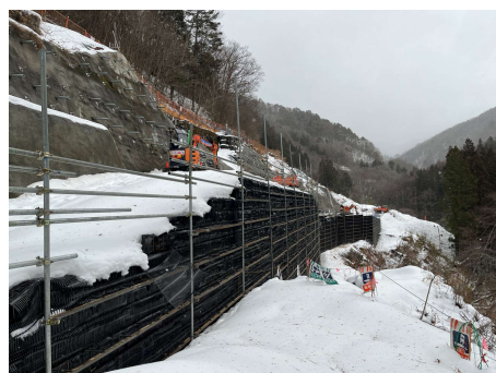
非常口ヤード進入路 補強盛土工 2025年2月13日
