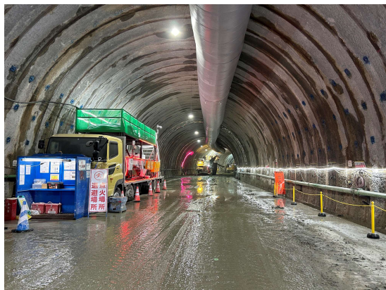
トンネル坑内（広瀬工区）
