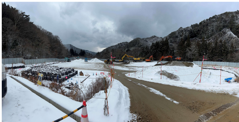
発生土仮置ヤード（広瀬工区）
