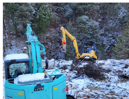
区間①迂回路 抜根工 2025年1月7日
