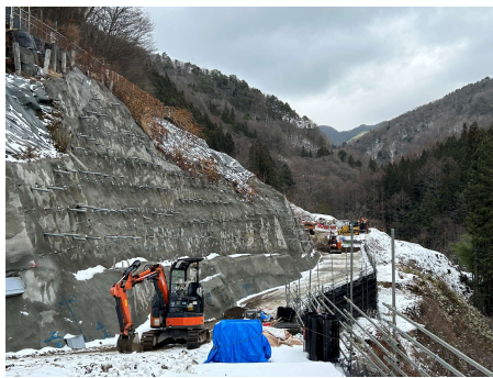
非常口ヤード進入路 補強盛土工 2025年1月7日
