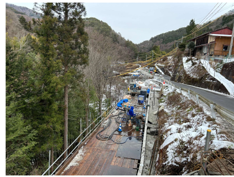
区間①上流 パンウォール工 2024年12月25日
