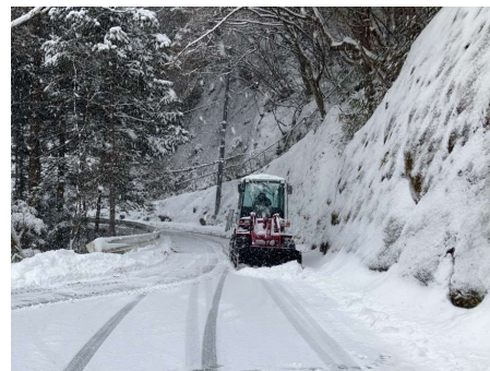
村道1-20号線 除雪状況 2025年1月8日
