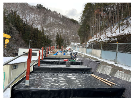
村道区間①下流 軽量盛土工 2025年1月9日
