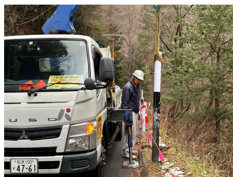
区間① ガードレール修繕工 2024年12月17日
