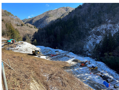
非常口ヤード 造成工 2024年12月24日
