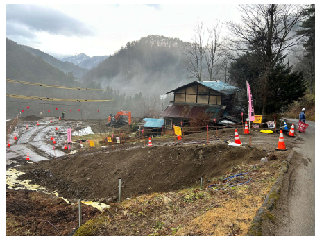
村道区間③ 萩の平ヤードから土砂運搬 2024年12月26日
