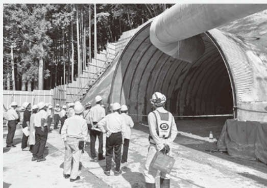
南木曽町広瀬工区トンネル掘削の様子
