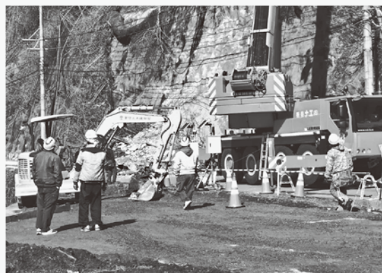
園原インター線崩落の復旧の様子
