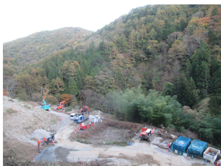
非常口ヤード 伐採工 2024年11月7日
