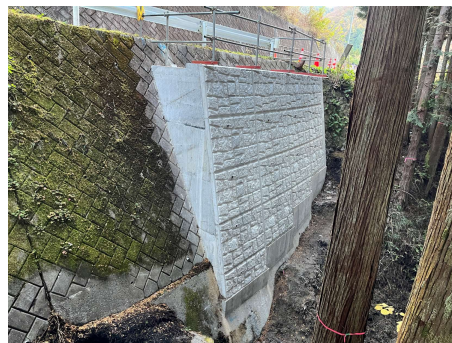
村道区間④ パンウォール工 2024年11月13日
