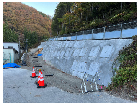
村道区間①下流 基礎工 2024年11月13日
