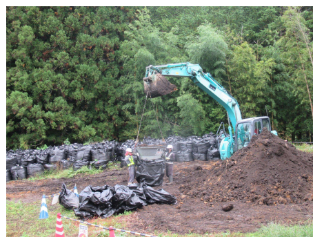
区間①迂回路 大型土のう作成 2024年10月28日
