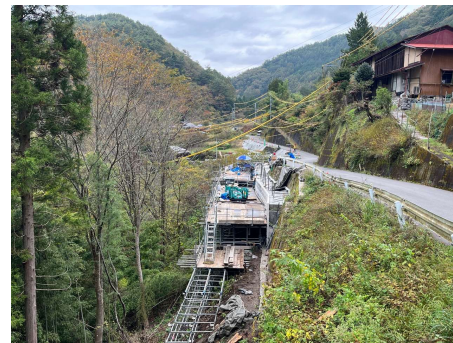
村道区間①上流 パンウォール工_アンカー打設 2024年11月5日
