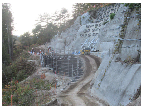
非常口ヤード進入路 補強盛土工 2024年11月7日
