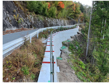
村道区間⑤ パンウォール工 2024年11月13日
