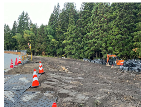
区間①迂回路 ヤード造成工 2024年11月13日
