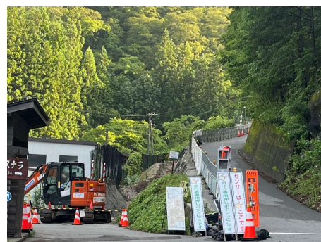
村道区間①下流 土工事 2024年7月13日
