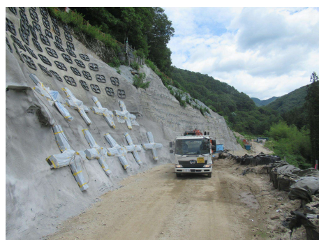
非常口ヤード進入路 土工事 2024年7月9日
