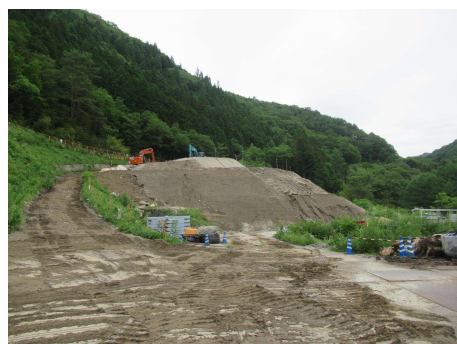
非常口ヤード 造成工事 2024年7月2日
