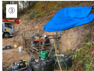
③ 【削孔】 ボーリングマシンで孔を掘ります。（削孔）
