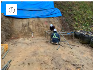
① 【足場組立】 ボーリングの高さに合わせて足場を組み立てます。
