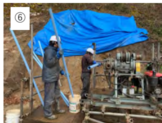
⑥ 【水抜パイプ設置】 水抜パイプを設置します。
