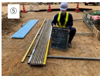
⑤ 【削孔長確認】 ケーシング全長を確認します。全長－残尺＝削孔長になります。
