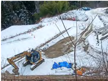
萩の平非常口ヤード のりめんこう 土工事（切土・法面工） 2024年1月15日
