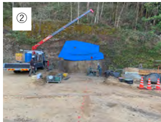
② 【ボーリングマシン搬入】 ボーリングマシンを搬入します。
