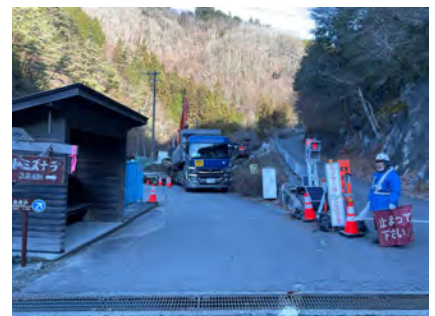
村道区間①下流 廃棄物搬出 2023年12月14日
