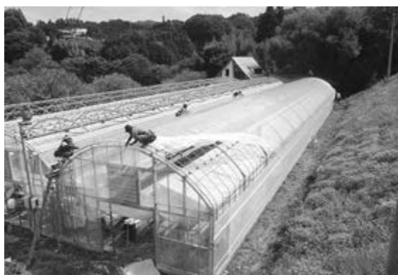
外張り改修工事の様子
