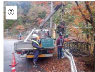
② 【足場工】 足場を組立て、試掘した 場所にボーリングマシン をセットします。
