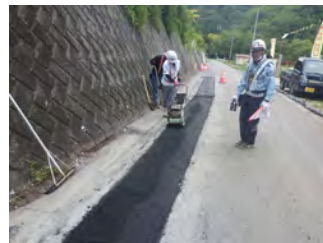
石割水道工事 舗装工 令和5年6月15日
