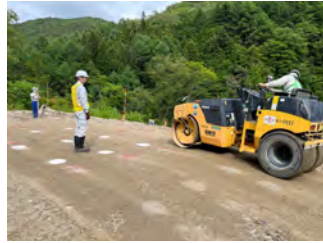
萩の平ヤード進入路 試験盛土 令和5年6月23日
