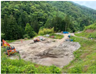
萩の平 非常口ヤード 令和5年6月15日
