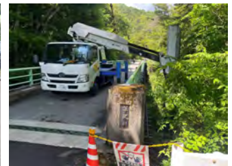
深沢橋補修工事 吊足場撤去 令和5年6月13日
