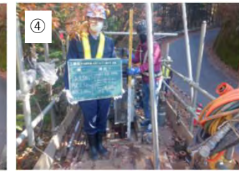
④ 【削孔長検尺】 所定の長さ掘ったこと を確認しています。
