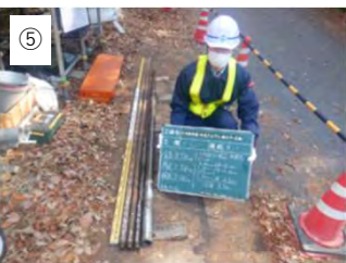
⑤ 【削孔長検尺】 ロッドの長さから孔から出 ている長さ(写真④)を差し引 いて長さを確認します。
