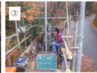
③ 【掘進工】 ボーリングマシンで掘進 します。
