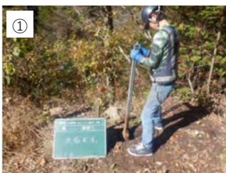
① 【試掘】 埋設管が無いか、人力で1m 試掘します。
