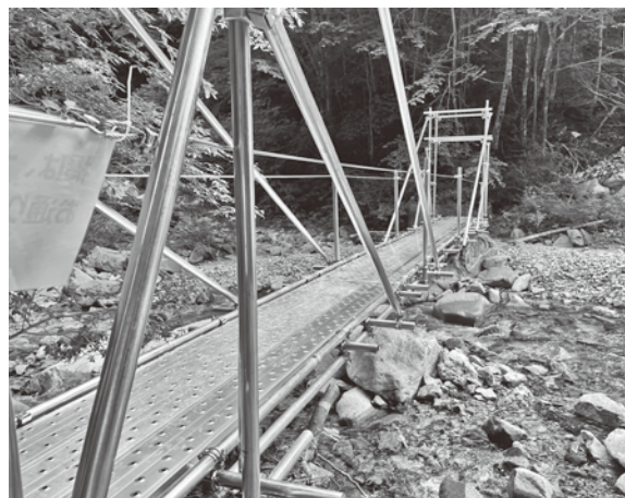
広河原登山口 復旧した橋
