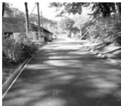
村道改良工事 (2-26号線浪合もみじ平)
