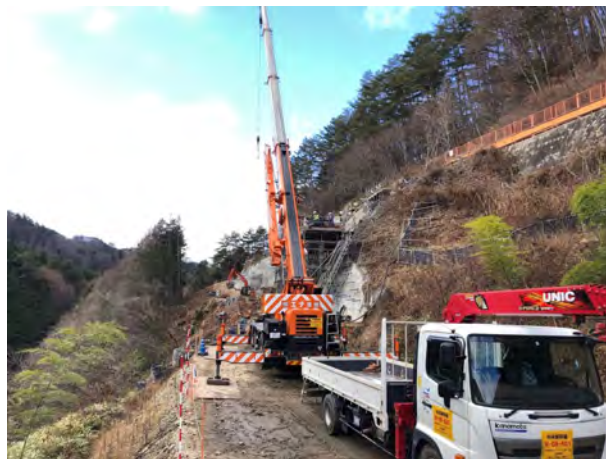
萩の平ヤード進入路法面工アンカー打設状況 令和4年12月7日
