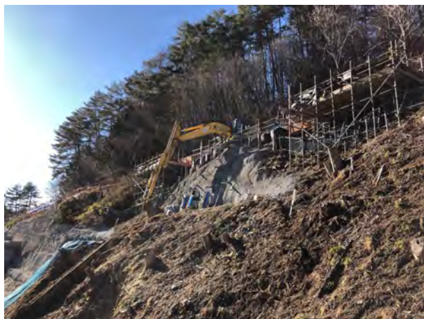
萩の平ヤード進入路切土状況 令和5年1月10日
