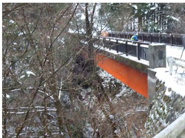
昭和橋補修完了 令和4年12月26日
