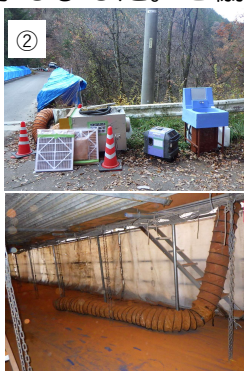
② 塗装に含まれる鉛が外に漏れないよう密閉して集塵機で集めました。
