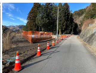
石割水道工事 ヤード造成 令和5年2月15日
