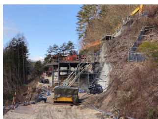
萩の平ヤード進入路 終点側 令和5年1月17日
