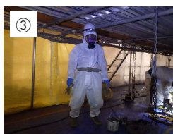
③ 【防護服着装】 塗装撤去作業で鉛により身体が汚染されないよう防護服を着装しました。
