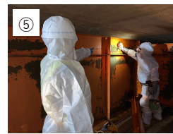
⑤ 【脱脂洗浄】 被塗面の油分や金属粉等を落としました。表面にセロハンテープを貼りテープがしっかり密着する事で脱脂できている事を確認をしました。
