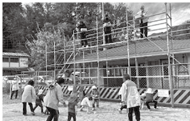
屋上からの餅投げに園児も喜ぶ上棟式（9月）
