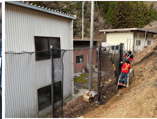
区間①下流 落石防護柵設置状況 令和4年12月1日
