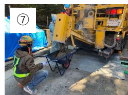
⑦ コンクリートができました。
