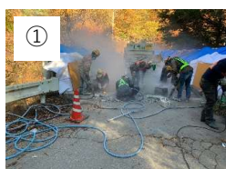
① 研って古い伸縮ジョイントを撤去します。
