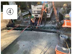
④ 新しい伸縮ジョイントを据え付けます。
