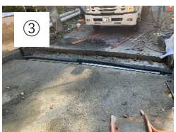
③ クローザーを設置します。
