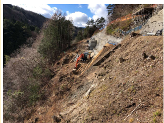
萩の平ヤード進入路 切土状況 令和4年12月7日
