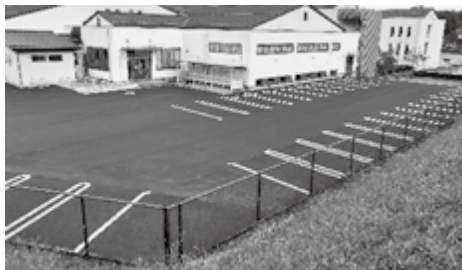
阿智中学校社会体育館の駐車場舗装
