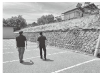
阿智中学校の防草シート敷設
