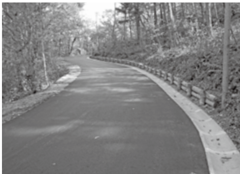
治部坂別荘内道路改良工事
