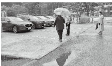
清内路小学校の駐車場舗装
