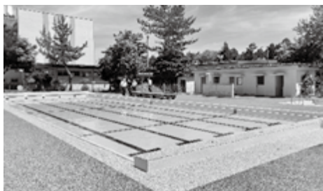
第二小学校プールの改修
