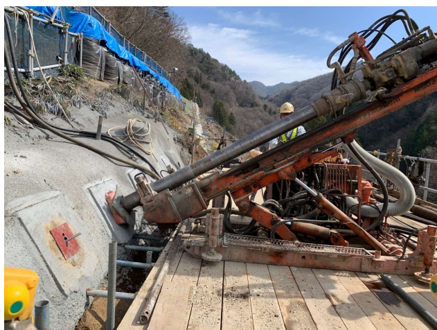
進入路(起点側) アンカー削孔施工状況
