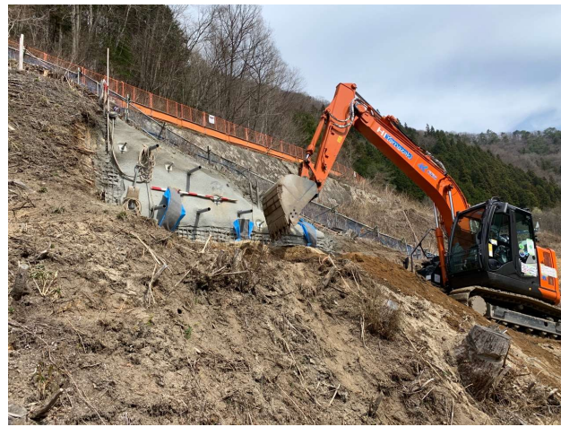
進入路(終点側) バックホウ切土施工状況
