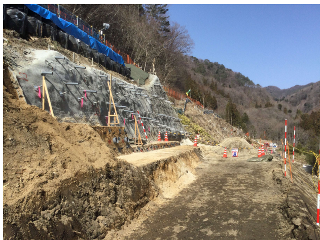
進入路(起点側) 令和4年4月
