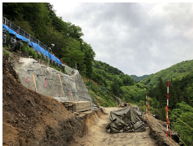
進入路(起点側) 令和4年5月
