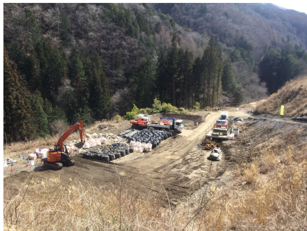
萩の平ヤード状況
