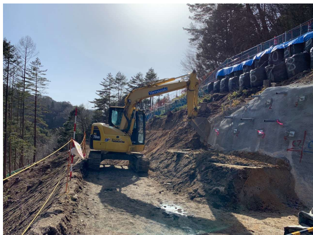
バックホウ切土施工状況
